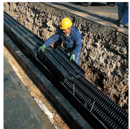
重機を使用しない布設
