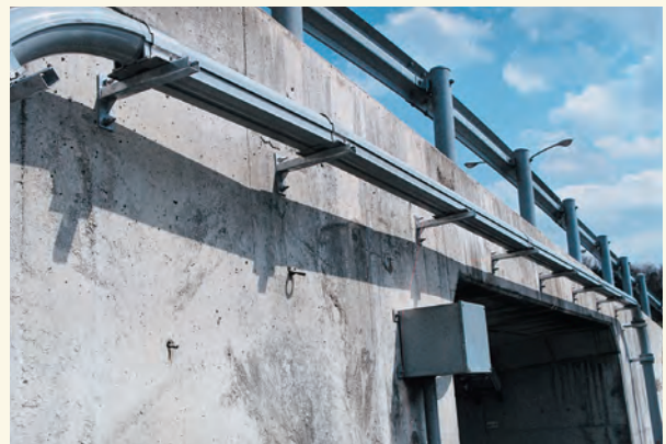
高速道路の管理区域内使用例
