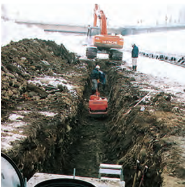
発生土による埋め戻し
