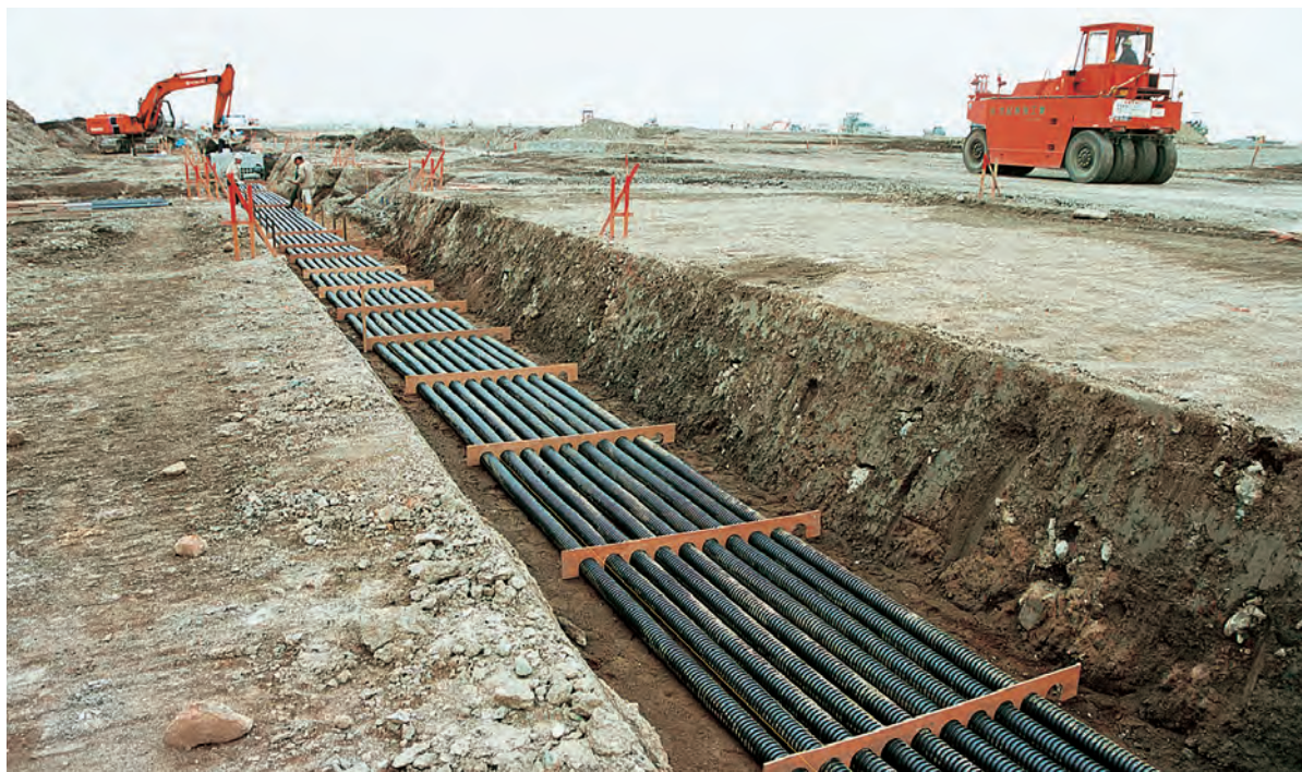
エフレックスは、JIS C 3653電力用ケーブルの地中埋設の施工方法 (昭和62年制定、平成16年改正) の波付硬質合成樹脂管の性能に適合し、管路式として使用できます。
